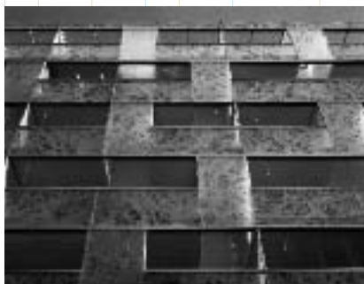
Wimbergergasse Delugan Meissl Foto: Margherita Spiluttini
