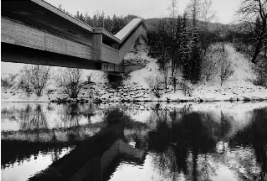
Mursteg Murau Conzett und Meili & Peter Foto: Margherita Spiluttini
